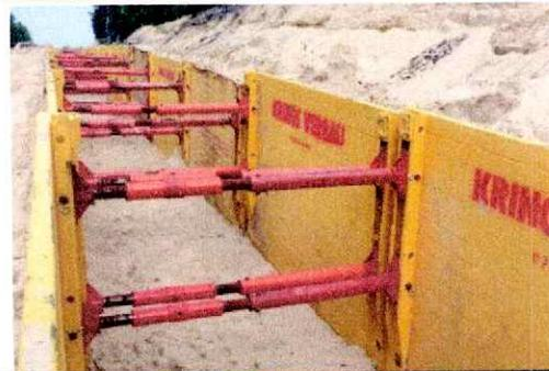
**Fig. 7 Entibado con apuntalamiento hidráulico**
